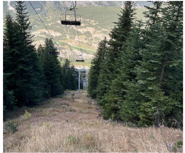
Vue depuis la zone intermédiaire de la ligne
