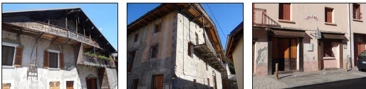
Photo 30 : Echantillon de façades
